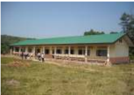
Bâtiment d'école en construction
